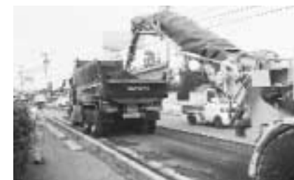
市道舗装打ち替工事
