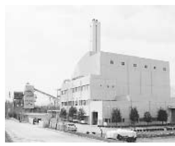
穂高クリーンセンター焼却施設
