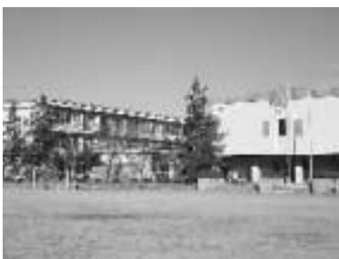
耐震大規模改修予定の豊科北小学校
