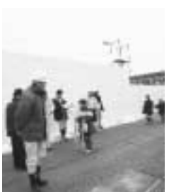
穂高北小学校建設現場視察
