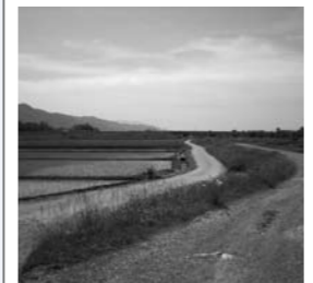
犀川橋下流右岸道路
