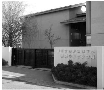
犀川安曇野流域下水道穂高中継ポンプ場
