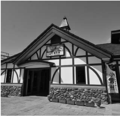
信州DCに向けて改築された豊科駅
