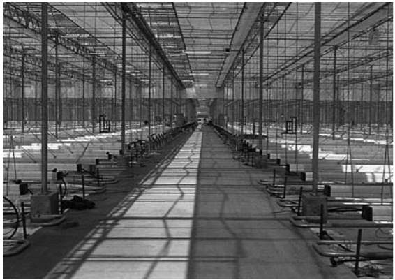
目的達成はいつ？（当時建設中のトマト栽培施設）
