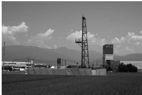
地下水源の試掘工事現場 (三郷温)
