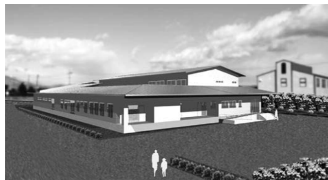
〈安曇野市北部学校給食センター完成予想図〉 穂高学校給食センターが築26年以上経過し、施設設備及び厨房機器等が老朽化したため、建て替えを計画。アレルギー調理室、炊飯室を新たに備え、学校給食衛生管理基準に対応した施設として計画されました。また、景観にも配慮し、高さ10m以内、切妻屋根の建物形状とします。
