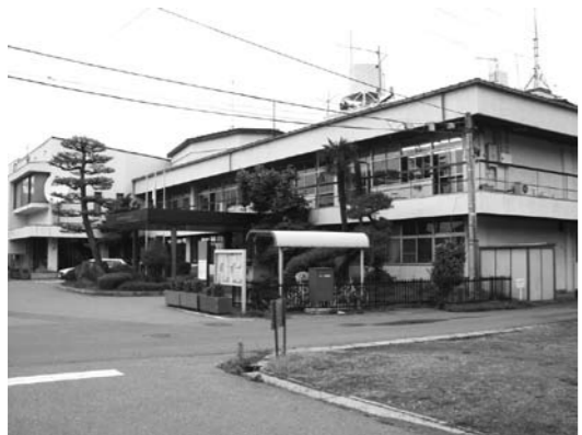
建替えが予定されている明科総合支所
