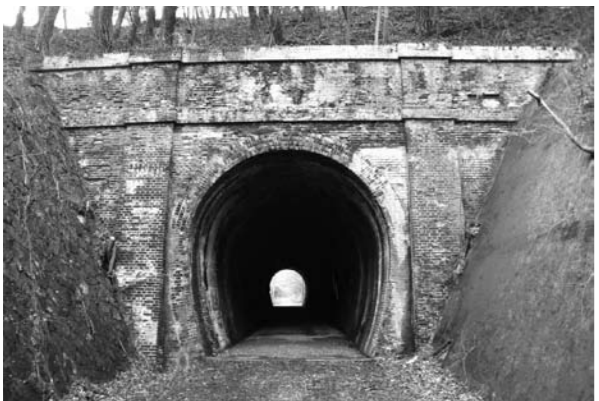
JR 廃線敷の漆久保トンネル（明科）
