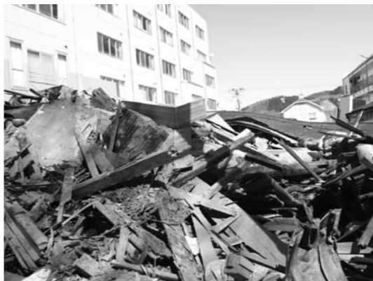
宮城県石巻市津波災害地
