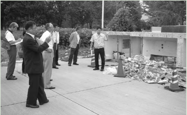
劣化状況を調べるため取り外された橋梁部材
