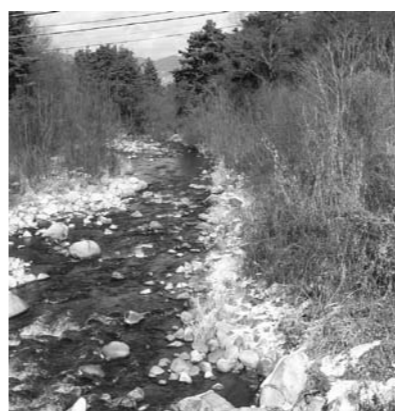
堤防が無い烏川右岸(烏川橋付近)
