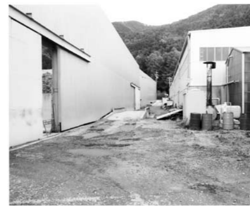
2011年11月8日後の死亡事故現場
