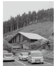
薪ボイラー利用の鮫川村保養施設
