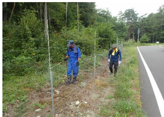
電気柵緩衝帯への除草剤散布作業 (堀金岩原)
