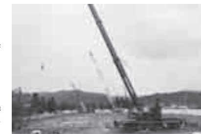
基礎工事が始まった本庁舎
