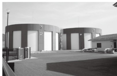
豊科高家配水池
