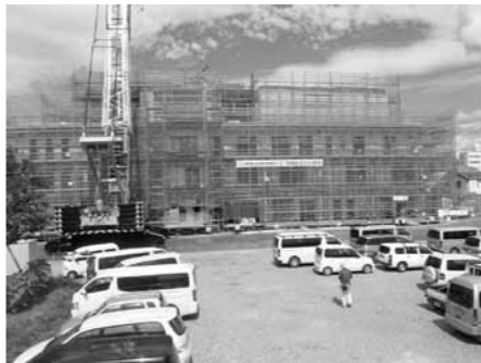
建設中の新本庁舎
