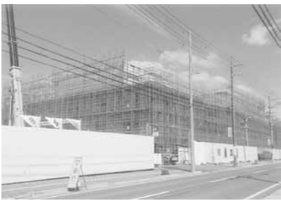
竣工間近な新本庁舎
