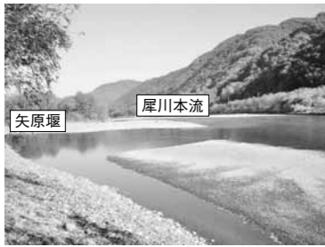
河床の安定対策が望まれる一級河川犀川
