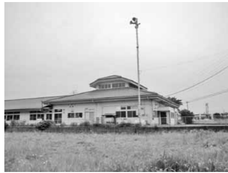
デジタル防災無線屋外スピーカー
