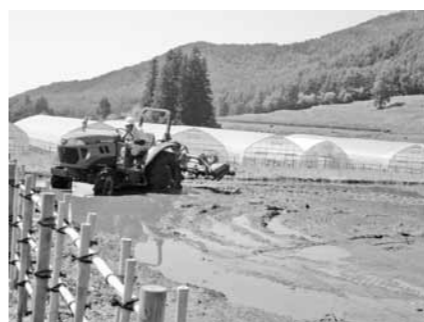
観光農園と国営公園内の作業風景
