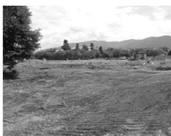
造成工事が始まった庁舎建設場所
