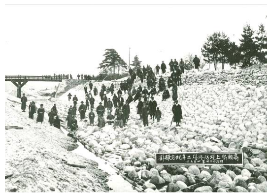
高瀬川橋上堤防修繕工事記念写真 (明治 44 年)
