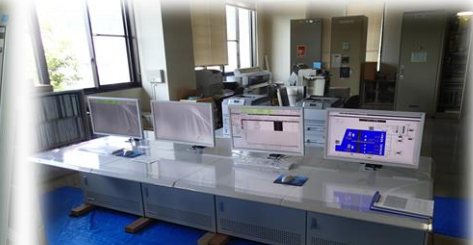
設備設置状況
