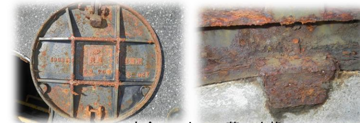
腐食マンホール蓋の交換
