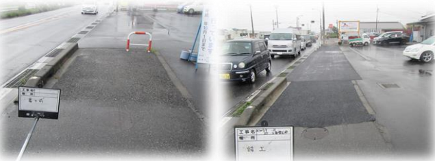
上原工区管渠工事
