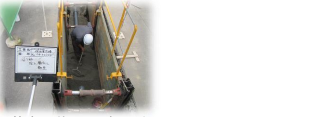
管布設状況(開削工法)
