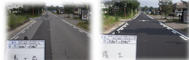
豊里地区路面復旧
