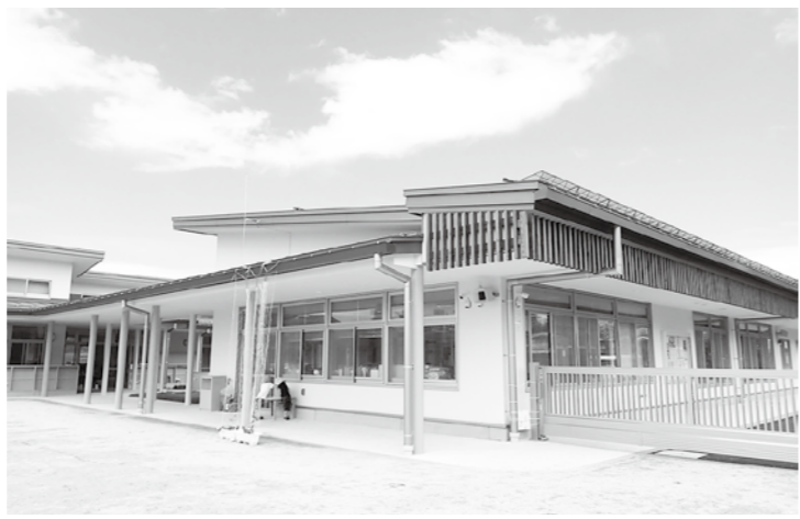
明科南認定こども園 新園舎外観
