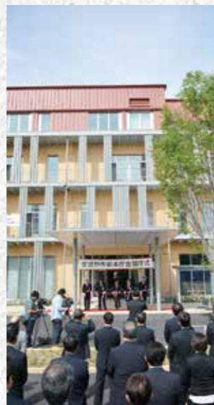
市役所本庁舎が完成
