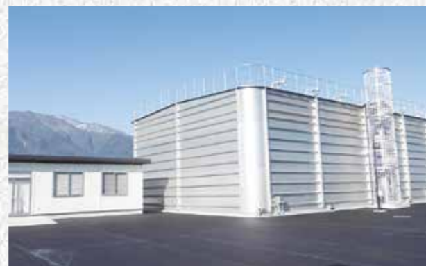
拠点排水池の整備が完了
