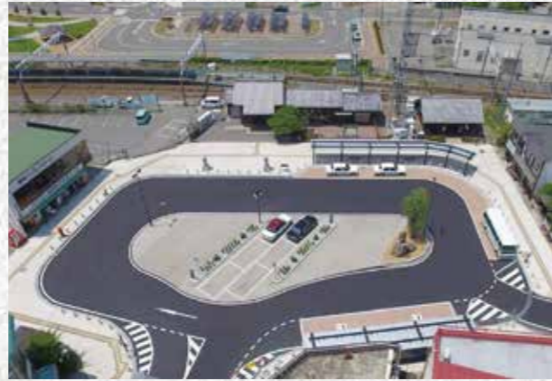
穂高駅前広場改修工事が完了
