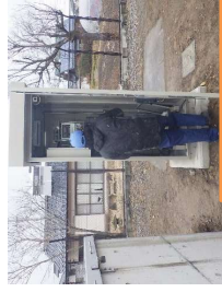
上原水源池 排泥弁制御盤
