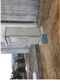
上原水源池 排泥弁制御盤
