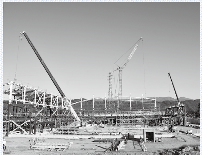
鉄骨工事施工の様子
