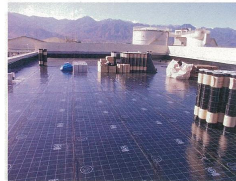
砂ろ過棟屋根防水工事
