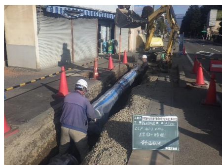
管吊り込み状況
