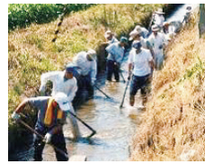
水路の清掃作業
