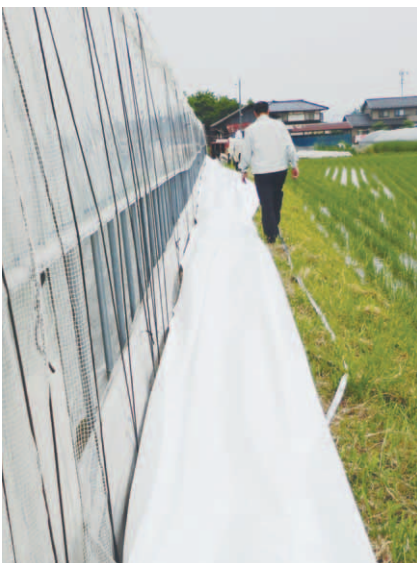
▲タイベックシート設置
