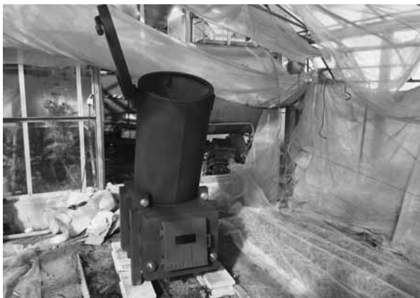
平成 26 年 1 月 27 日 薪ストーブ設置①
