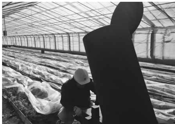
平成 26 年 1 月 27 日 薪ストーブ設置②
