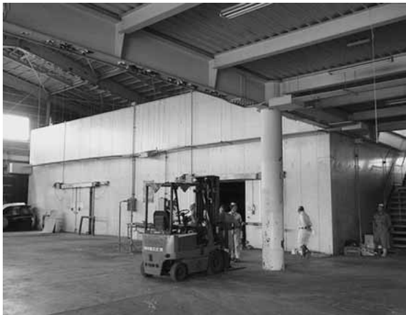
除湿機を設置した倉庫
