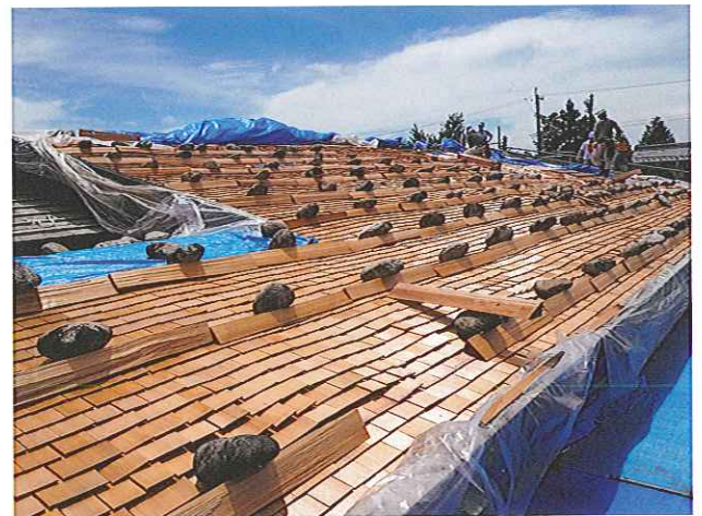
曾根原家住宅の屋根の葺き替え
