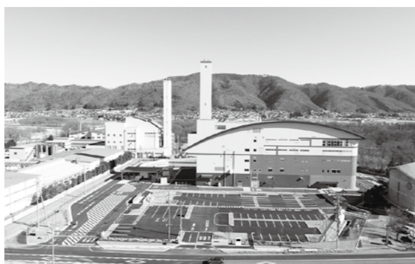
旧施設の隣接地に完成した新ごみ処理施設
