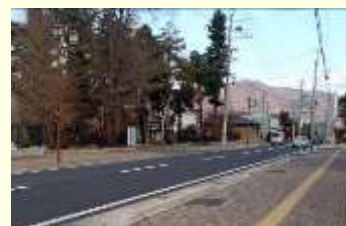
景観になじみやすい色を用いた舗装
