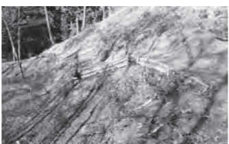
整備中のクロスカントリーコース
