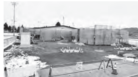
建設中の穂高北部児童館
