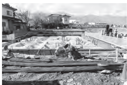
豊科上鳥羽の小規模保育所建設現場（令和3年12月中旬）
