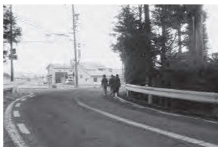
交通量が多く歩道のない危険な通学路（県道）
