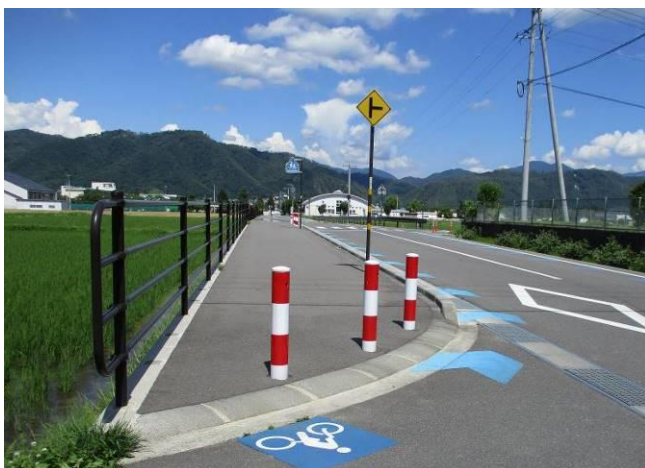
自転車走行指導帯（路面標示）
