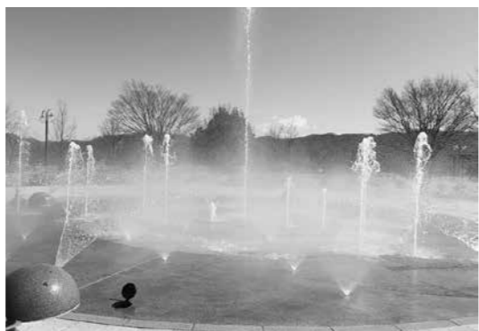
完成した豊科南部総合公園噴水広場
