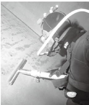
配水池タンク内清掃の様子。市内49カ所すべてに潜水士が潜って清掃します。
