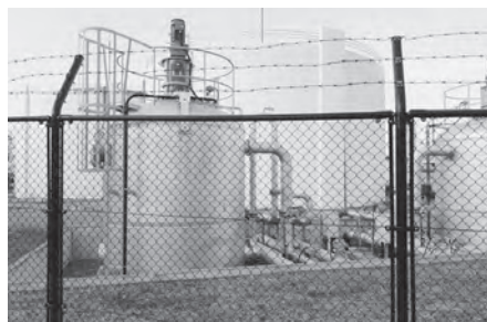
重要な社会基盤（真々部配水池）
