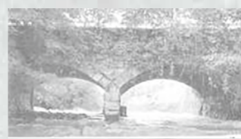
崩壊前のめがね橋
