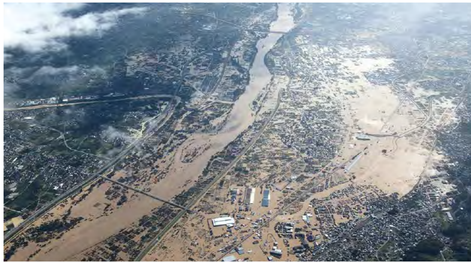
令和元年東日本台風(台風19号)は、甲信地方の他、関東地方や東北地方でも記録的な大雨となり、甚大な被害をもたらした。千曲川堤防が決壊し、甚大な被害が発生した長野市(千曲川小布施橋付近) 資料提供: 北陸地方整備局 千曲川河川事務所
