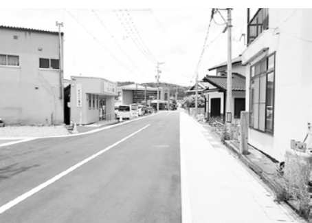
東の玄関口・明科駅周辺を整備
