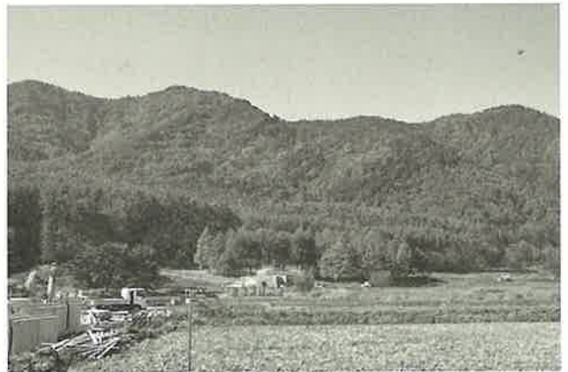
写真3 公園関連の工事が進む鵜鷹山麓
