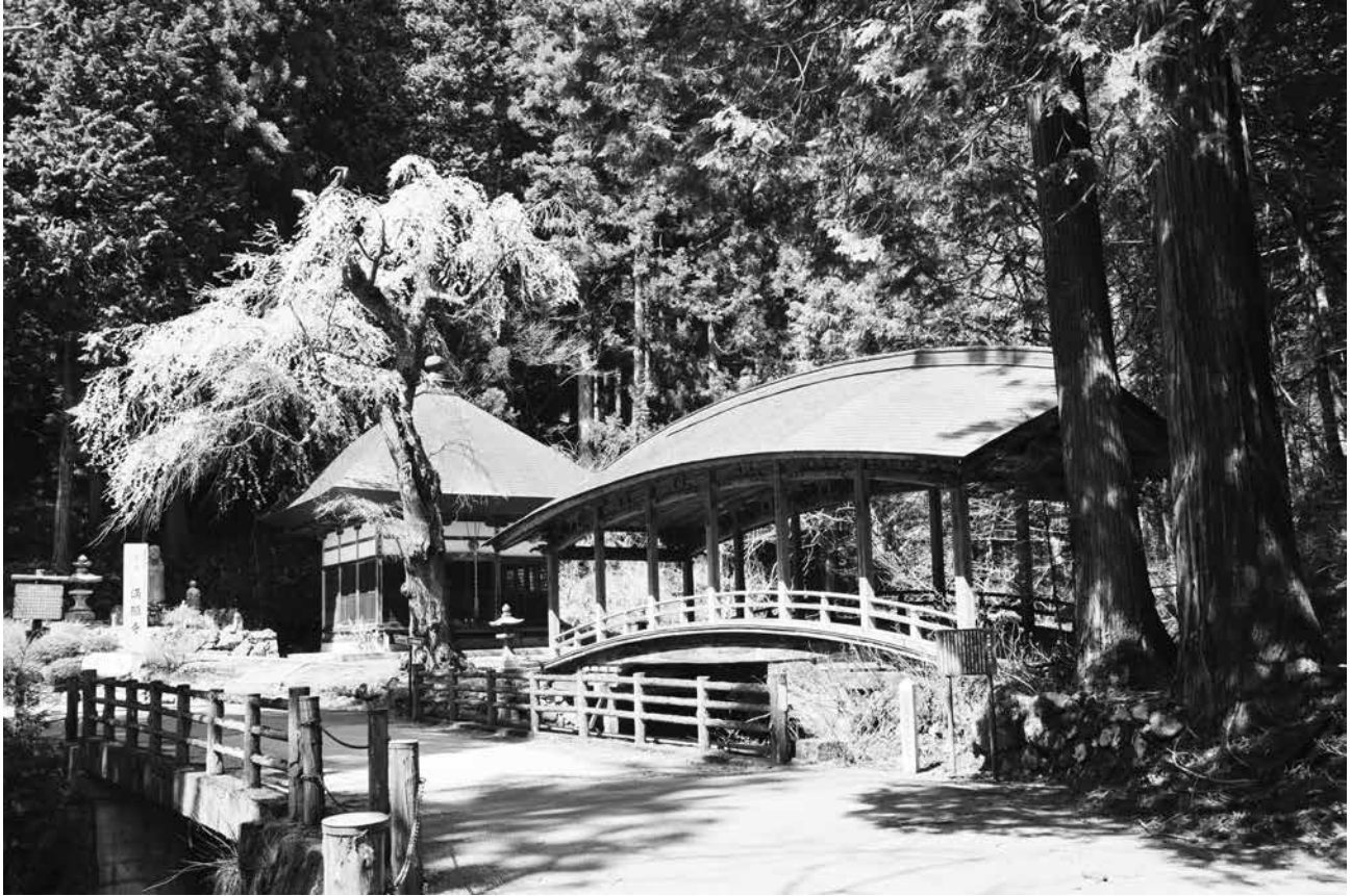
写真5 満願寺の微妙橋
