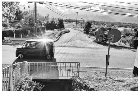
国道19号と明科地域のアクセス道路との 接続部分
