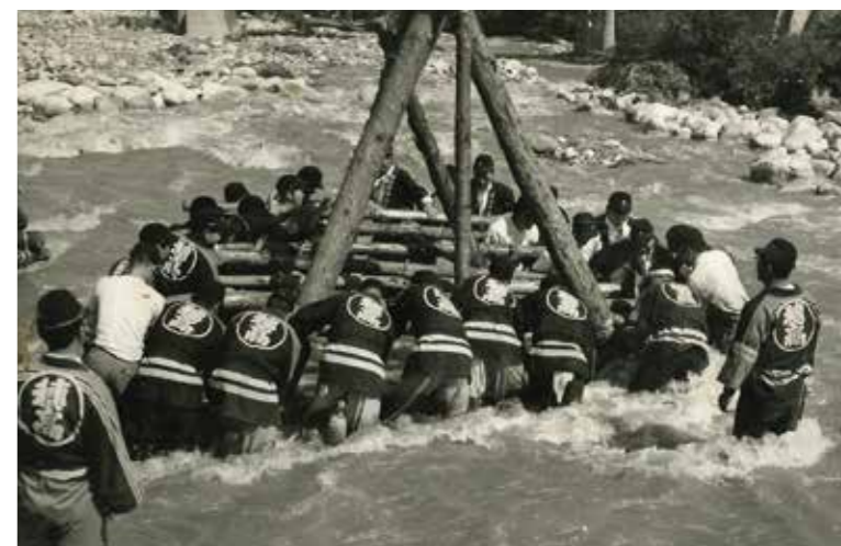
昭和34(1959)年9月 伊勢湾台風穂高川氾濫 聖牛(せいぎゅう・ひじりうし)入作業
