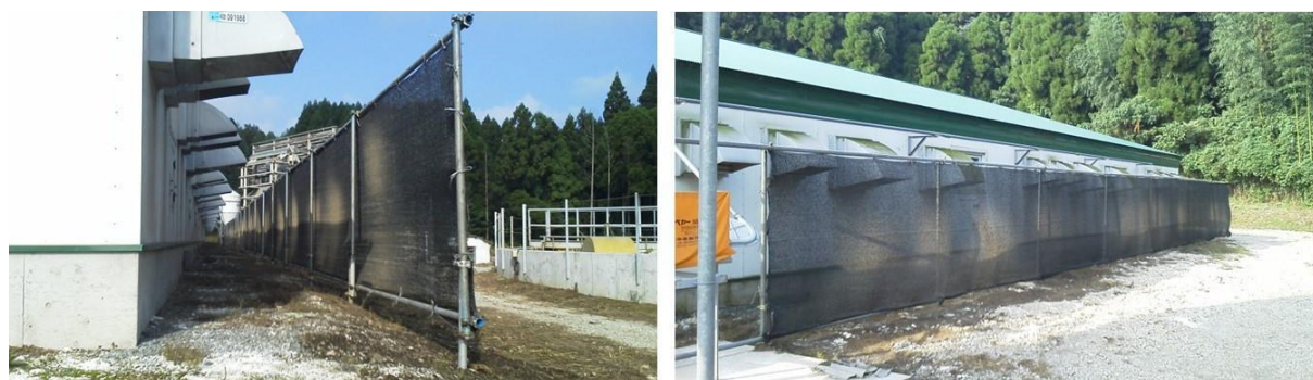
写真 排気口への遮蔽壁の設置
