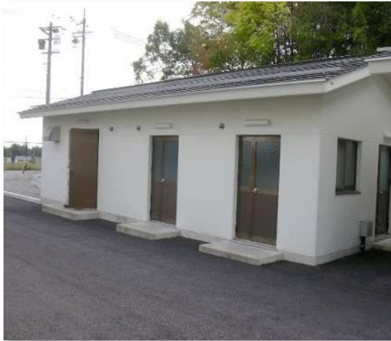
写真 2-1 ■ 穂高地域 宮城水源地 ポンプ室・滅菌機室
