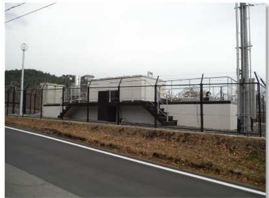
写真 4-8 ■ 小倉ポンプ場
