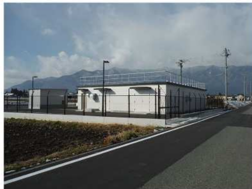
写真 4-9 ■ 野沢水源ポンプ場
