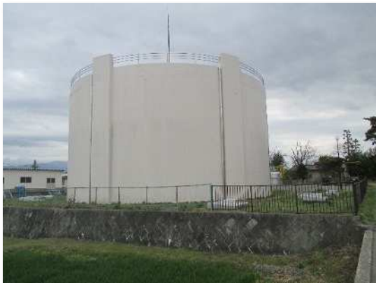
写真 4-7 ■ 真々部配水池
