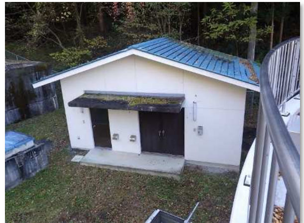
光配水池 電気室・滅菌機室
