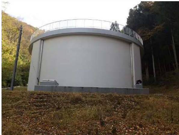
光配水池 PC タンク
