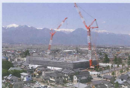
建設中の新本庁舎(安曇野赤十字病院より)
