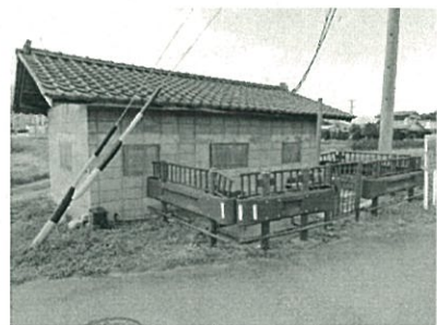
堰の辺に立つ、第二拾ヶ堰の取水ポンプ口の建物。
