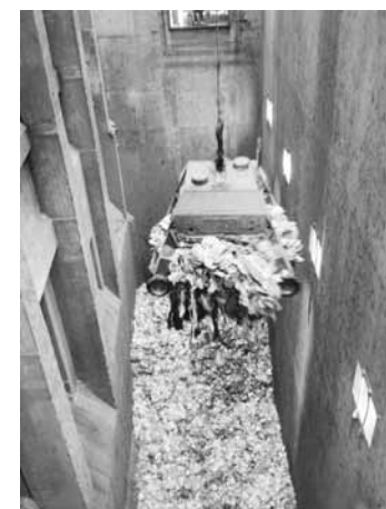
ごみ処理の様子（穂高クリーンセンター）
