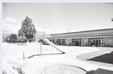
アルプス保育園が移転新築
