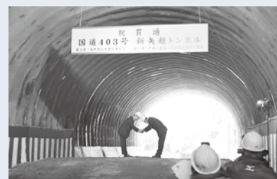
新矢越トンネルが貫通
