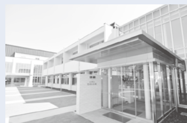
豊科公民館大規模改修工事が完了
