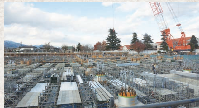
新本庁舎建設が始まる
