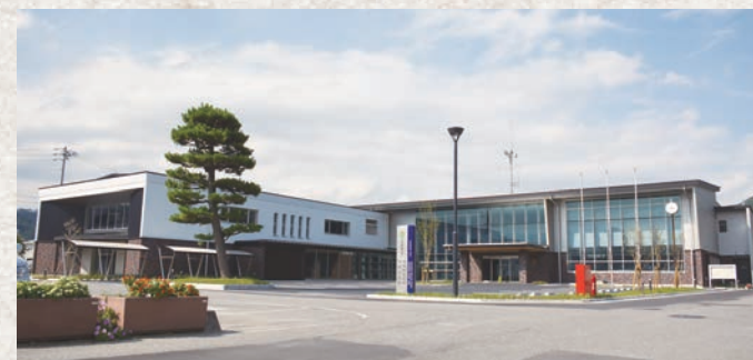
明科支所・公民館が完成
