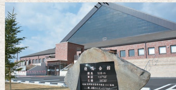
穂高会館の改修工事が完了
